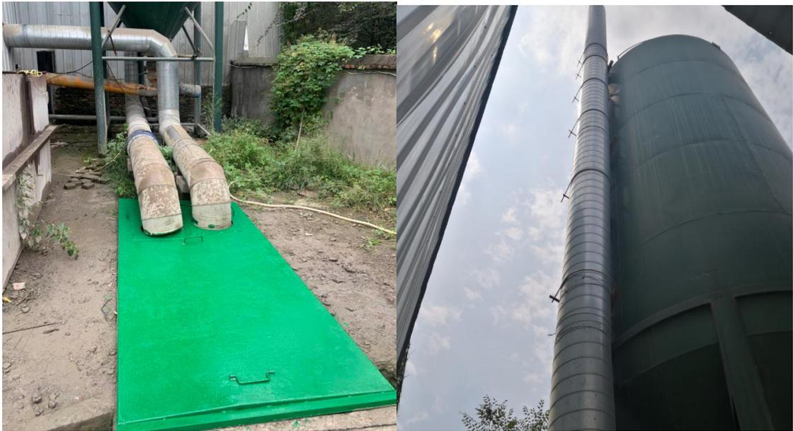
喷淋降尘+集气罩+水过滤除尘+15m 高排气筒
