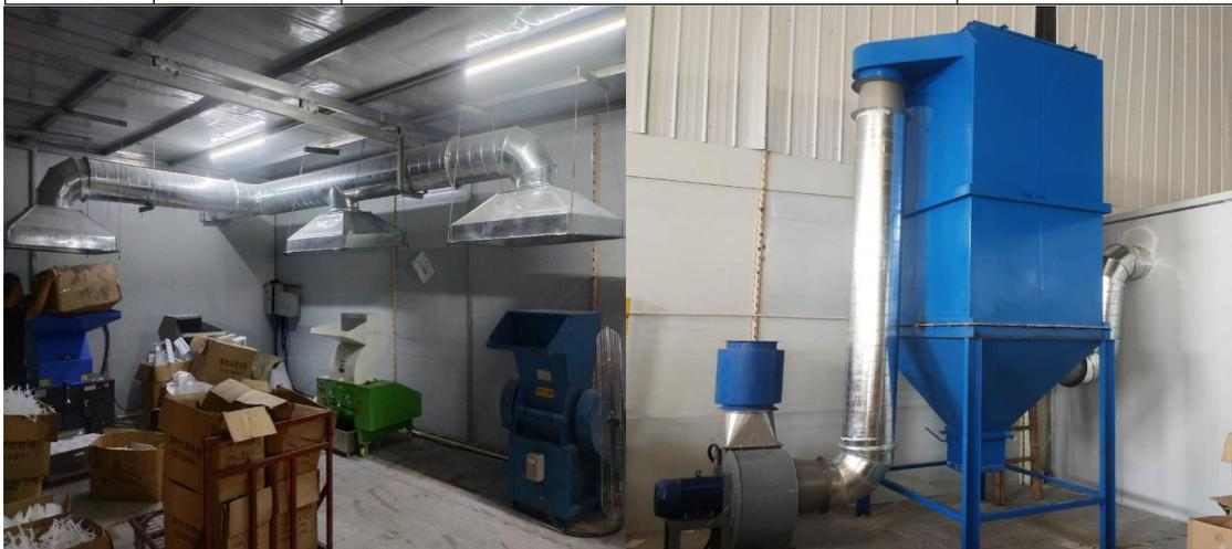
破碎粉尘：破碎房+集气罩+布袋除尘器
