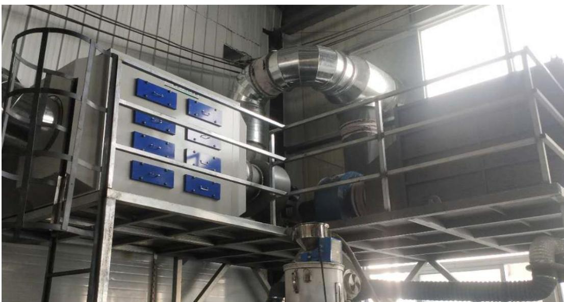
注塑有机废气：集气罩+活性炭吸附装置+15m 高排气筒
