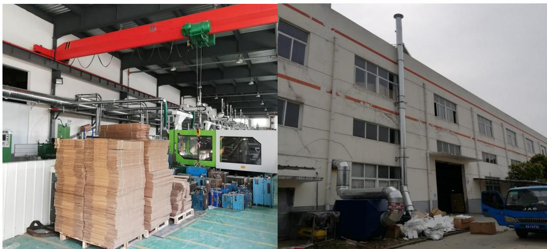
2#厂房注塑工序：集气罩+两级活性炭吸附装置+15m 高排气筒（DA002）
