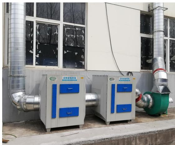
2#厂房丝印工序：集气系统（集气罩+封闭丝印房）+两级活性炭吸附装置+15m 高排气筒（DA002）
