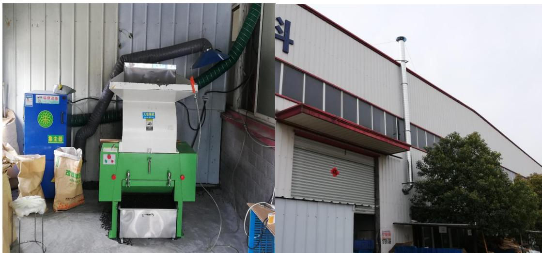
1#厂房破碎工序：集气罩+除尘器+15m 高排气筒（DA003）
